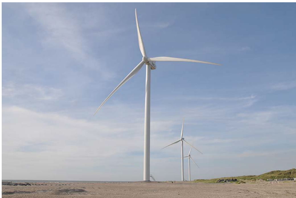
Slika 12: 3 MW vetrne turbine Vestas v Hvide Sande
